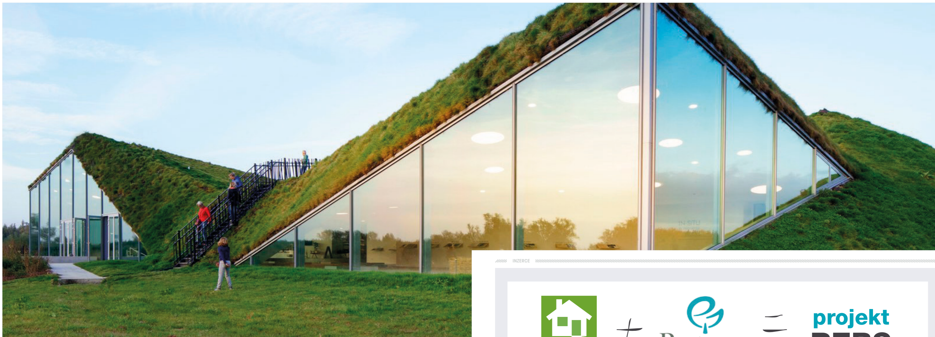
Zelená střecha je částečně nebo zcela pokrytá vegetací a půdou, nebo pěstebním substrátem vysazovaným nad hydroizolační membránu. Foto redakce
